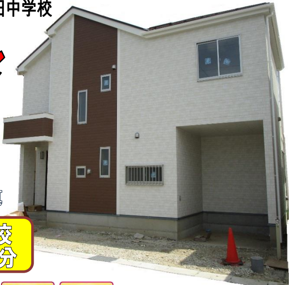
2号棟外観写真
