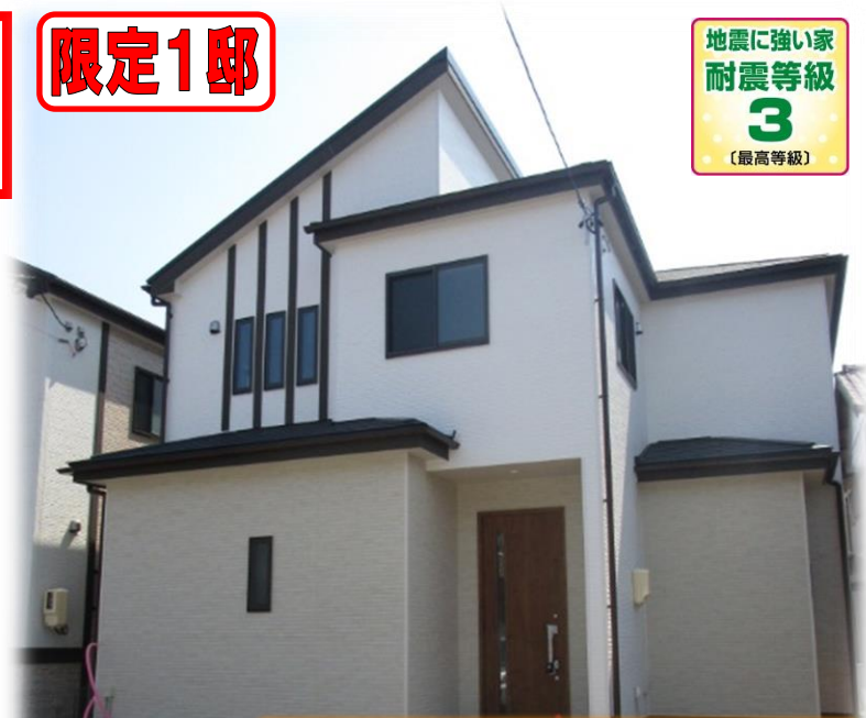
現地外観写真
